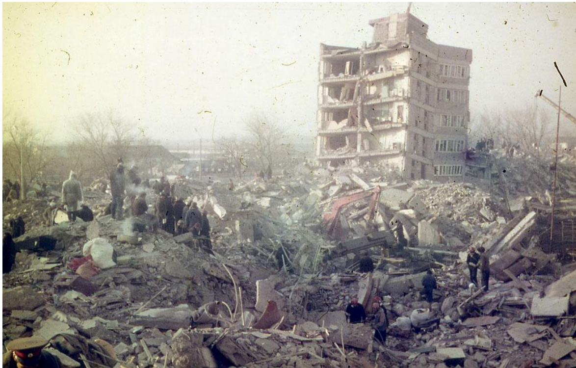
Землетрясение в Армении 7 декабря 1988г.
