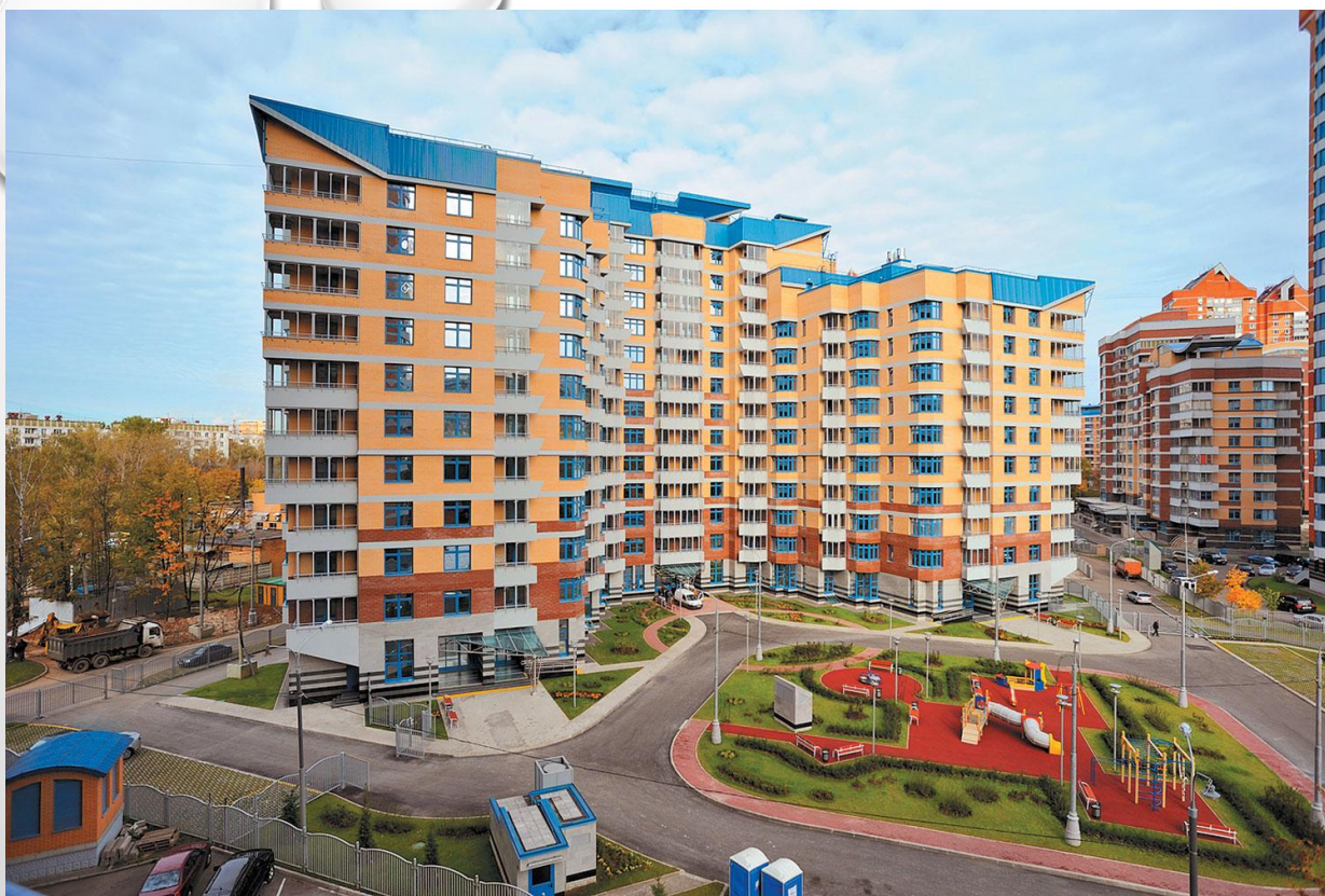
Многоквартирный дом – Apartman evi Жилой комплекс – Site Ap. No
