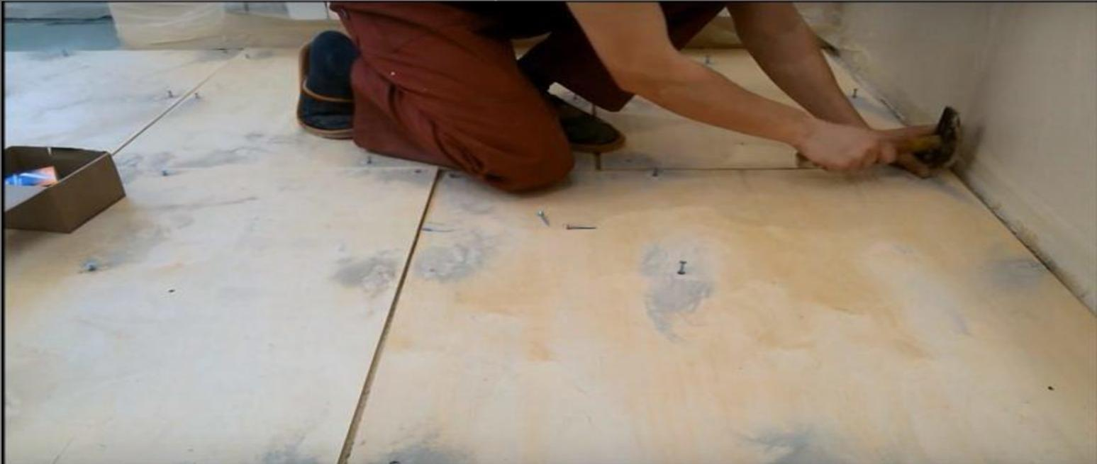
Если фанеру монтируют на стяжку, то на ее поверхность наносят слой клея, кладут листы фанеры и закрепляют при помощи саморезов или гвоздей. Необходимо учесть, что между листами должен оставаться небольшой зазор в 1-1,5 мм, также зазор в 3-4 мм следует отставить между плитами фанеры и стеной, это поможет в случае расширения фанеры не дать деформироваться паркетному покрытию.
