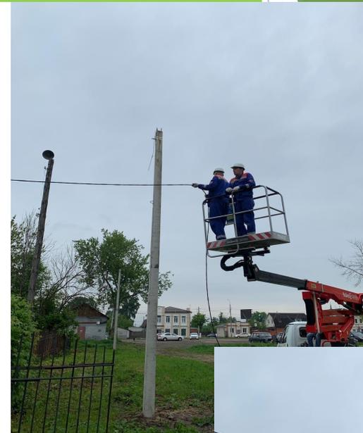
**-замена изношенных, старых не изолированных проводов на СИП протяженностью более 2 км.**
