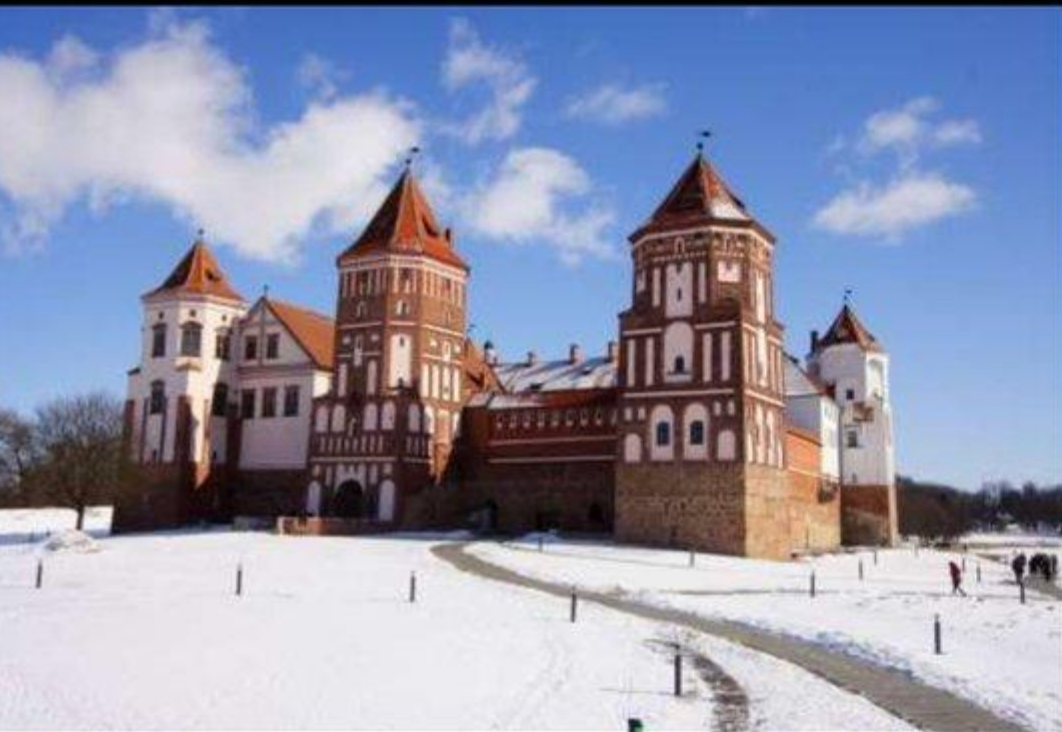
Мирский замково-парковый комплекс
