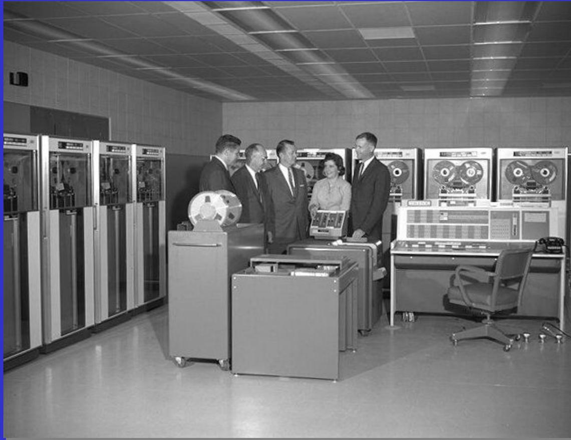
В 1959 г. на основе транзисторов IBM выпустила мейнфрейм IBM 7090 и машину среднего класса IBM 1401. Последняя использовала перфокарты и стала самым популярным компьютером общего назначения того времени (было произведено более 100 тыс. экземпляров).
