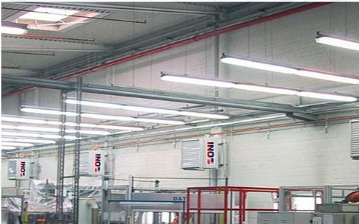
Специальные воздушные отопительные устройства обеспечивают производственный цех бесплатным отоплением, отработанным теплом машин
