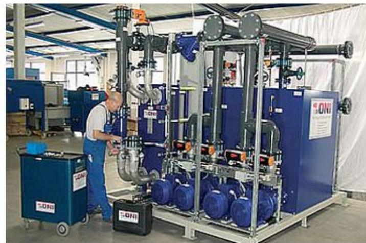
Холодильная установка предприятия производства медицинской техники с разгрузкой в зимнее время и с системой регенерации тепла ↘
