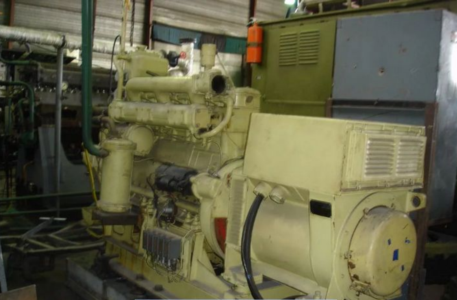
Судовой дизель Генератор ДГ-50
