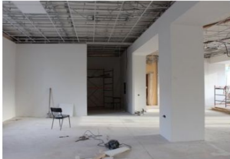
во время ремонта
