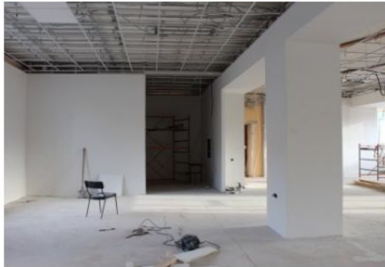
во время ремонта
