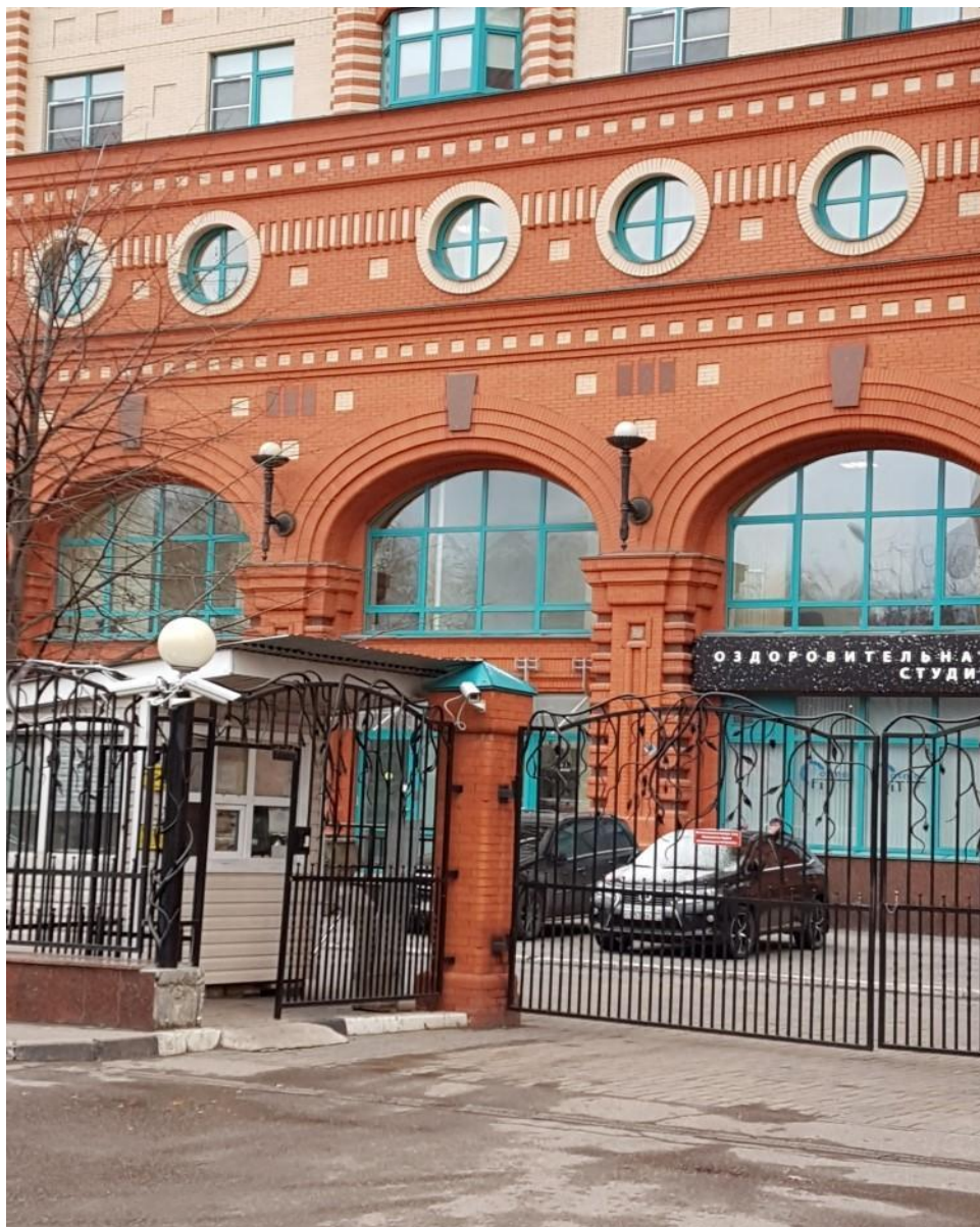
Калитка оборудована турникетом и камерой видеонаблюдения, рядом расположен пост охраны
