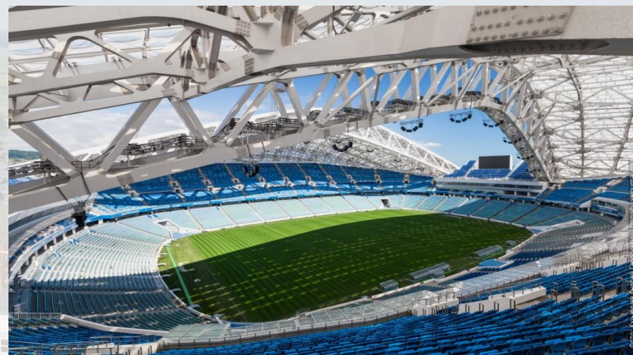
Металлоконструкции временной крыши Олимпийского стадиона «Фишт» Общий объем 4 200 тонн
