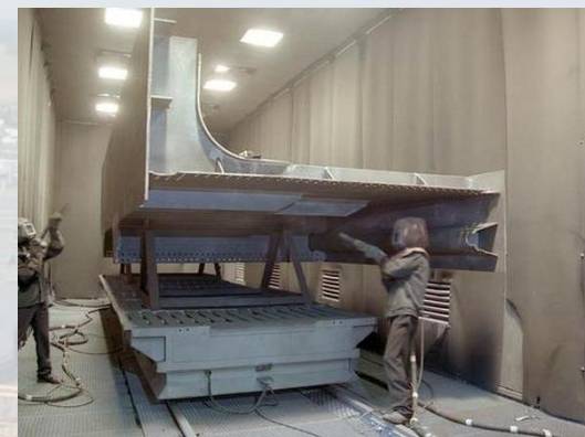
Дробеструйная камера «SCHLICK», «Heinrich Schlick GmbH», Германия, «Shotblaster», Финляндия
