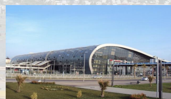
Металлоконструкции ЖД вокзала Адлер г. Сочи, 6500 тонн
