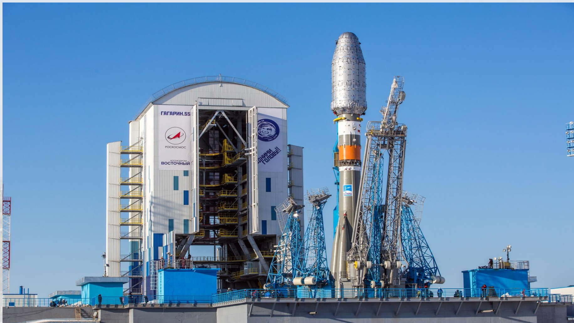
Мобильная башня обслуживания, Космодром «Восточный» Общий объем 1200 тонн
