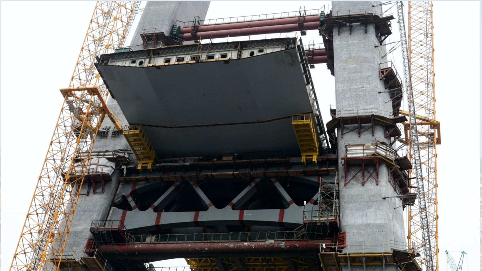
Монтаж металлоконструкций моста на о. Русский (г. Владивосток)
