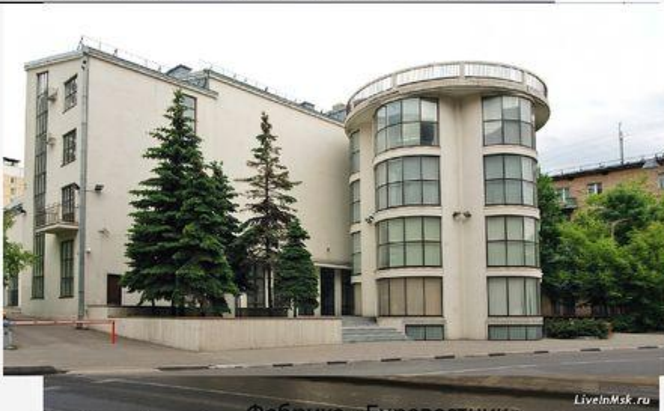
Фабрика «Буревестник» Рабочий клуб в Москве. Архитектор К.С.Мельников
