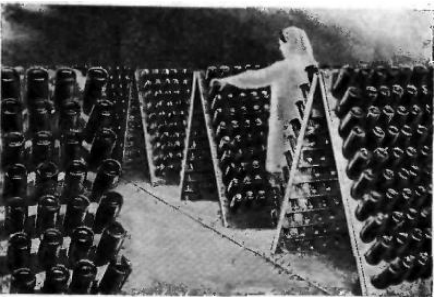
Рис. 169. Сведение осадка на пробку (ремюаж) на шампанском заводе «Абнав-Дюрсо».
