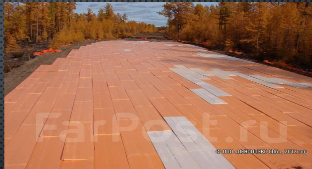
Схема укладки пенополистирольных плит
