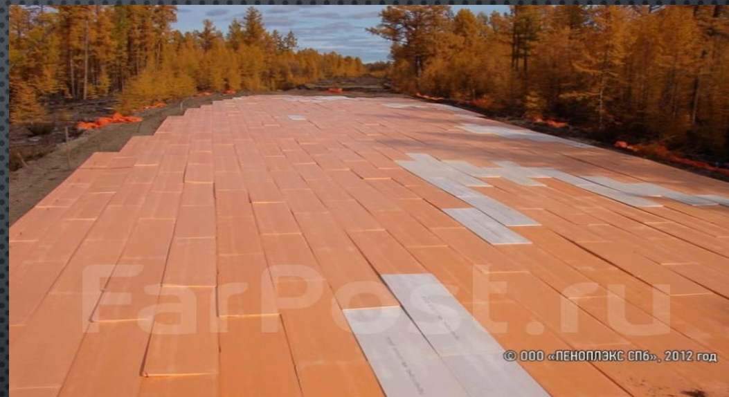
Схема укладки пенополистирольных плит
