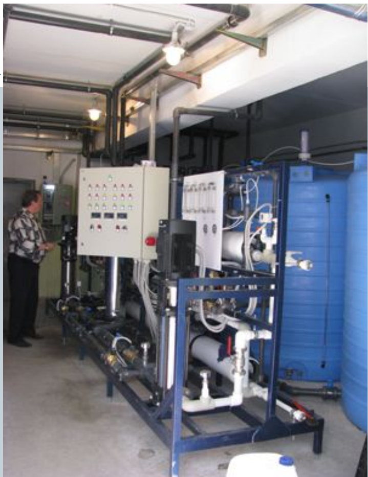
Станция водоподготовки для гальванического цеха
