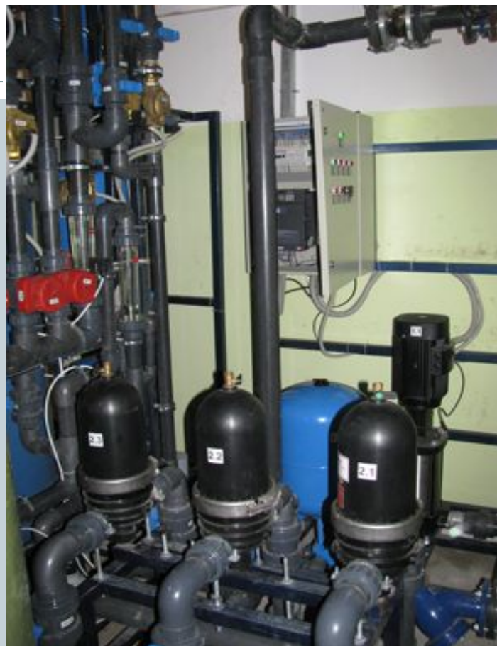
Станция водоподготовки для гальванического цеха
