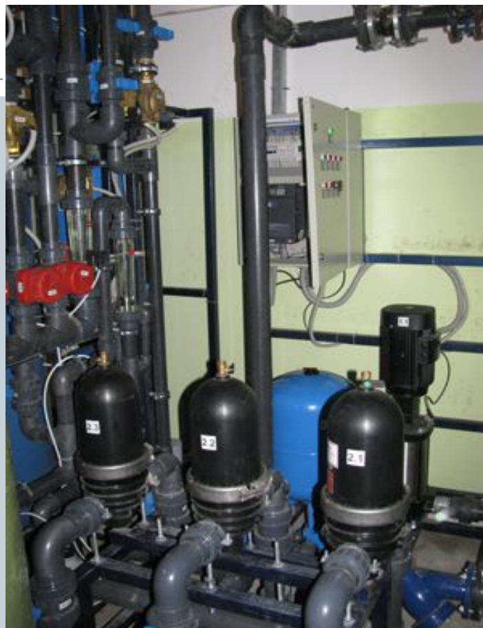
Станция водоподготовки для гальванического цеха
