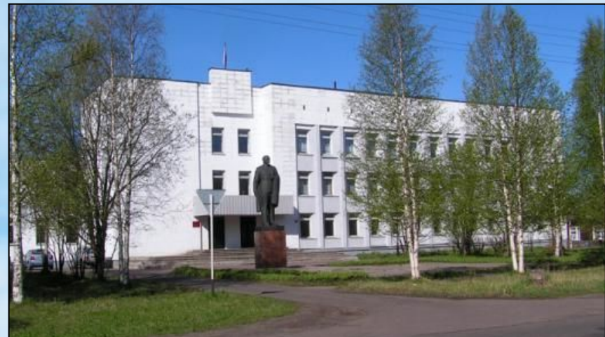
Здание районной администрации
