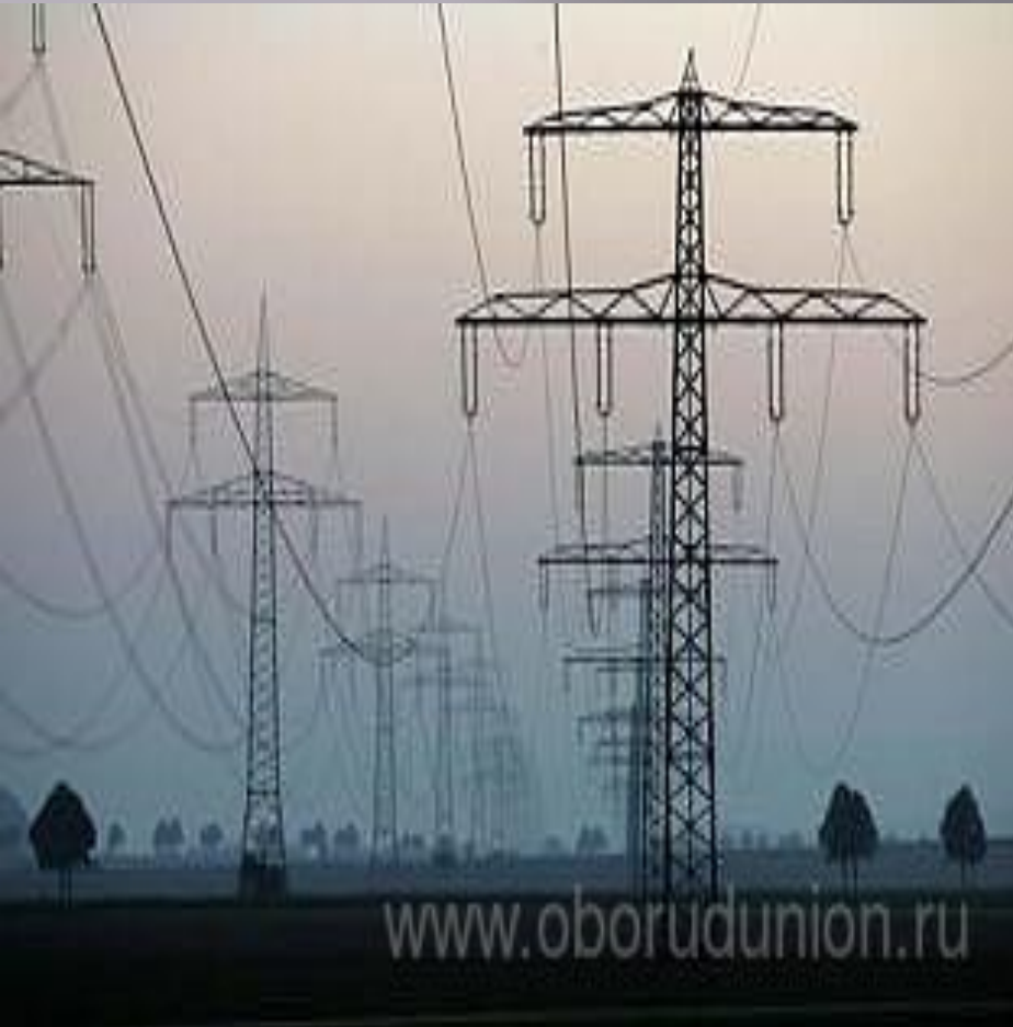
Конструкции угловых опор
