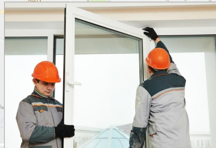
Установка окон и дверей
