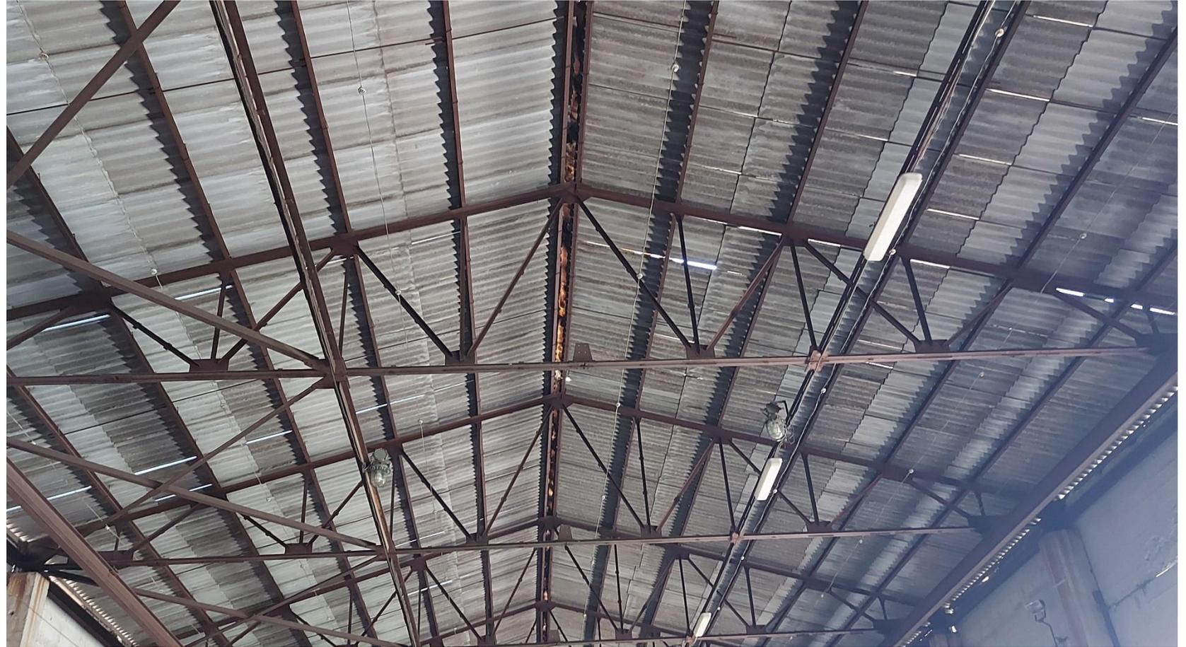
Провести ремонтные работы кровли точечно в местах, где имеются просветы и разошлись стыковочные швы между шифером.
