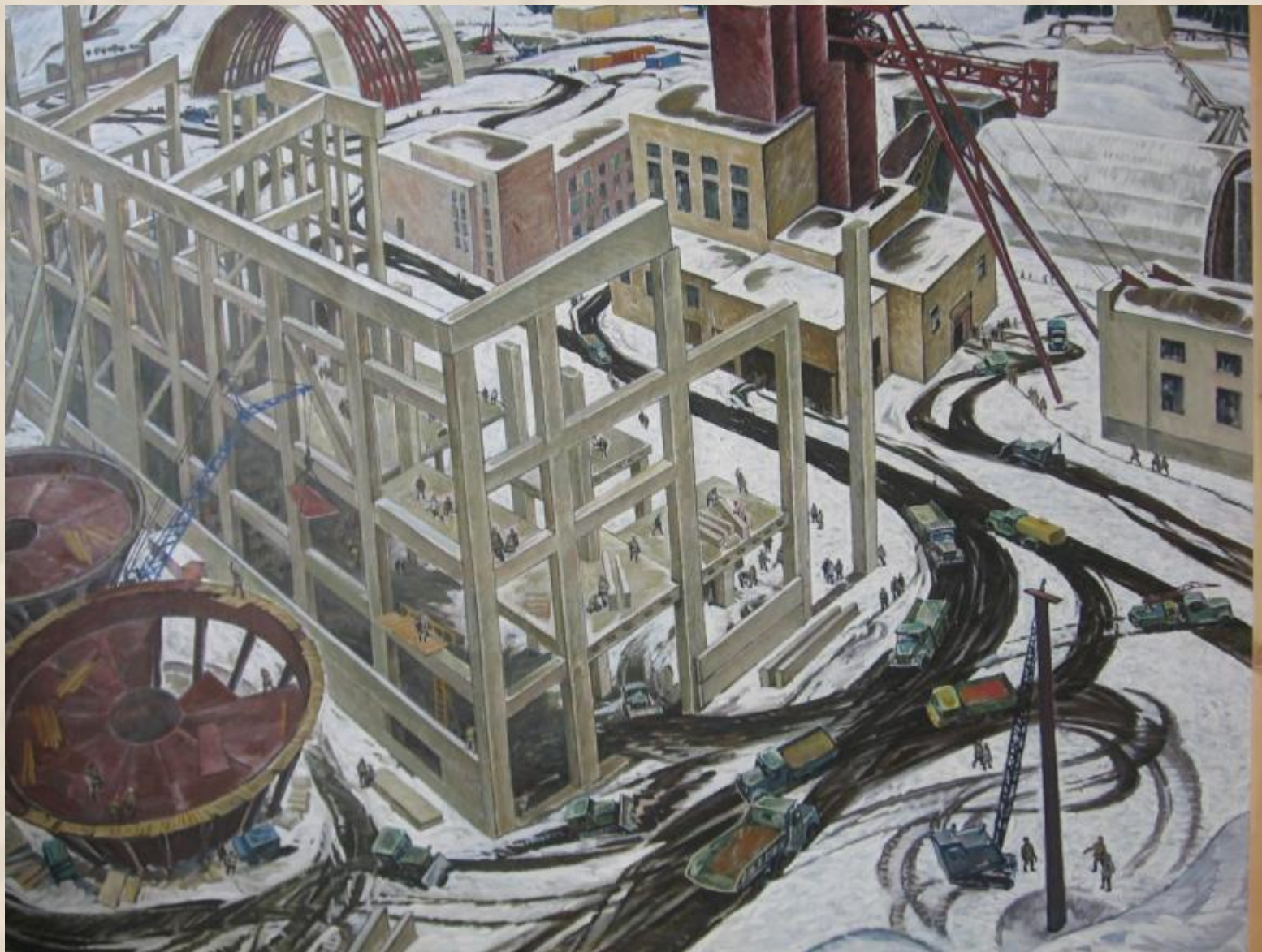
А.Тумбасов «Строительство калийного комбината»
