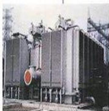
Сверхвысоковакуумный трансформатор 1050 кВ / 3000/3 МВА
