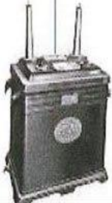
Трансформатор 50 кВ / 4 кВА
