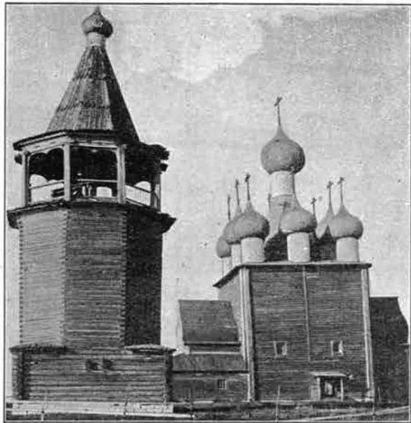
Рис. 99. Чухченемско-Ильинская церковь 1657 г. Колокольня 1783 г.
