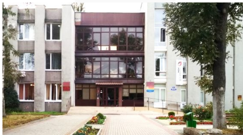
ремонт в Балтийском отделе с выделением обособленного помещения IV квартал 2021 года
