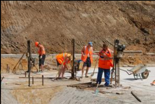
1. Бурение скважин, погружение инъекторов
