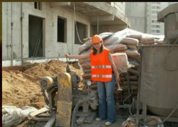
3. Закачивание раствора насосом
