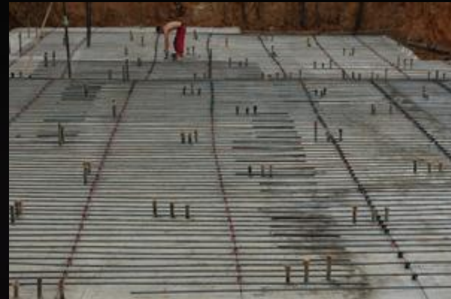
2. Гидроизоляция, вязка арматуры
