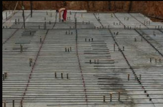
**Монолитная ж/б плита**
