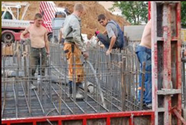
3. Заливка цементного раствора
