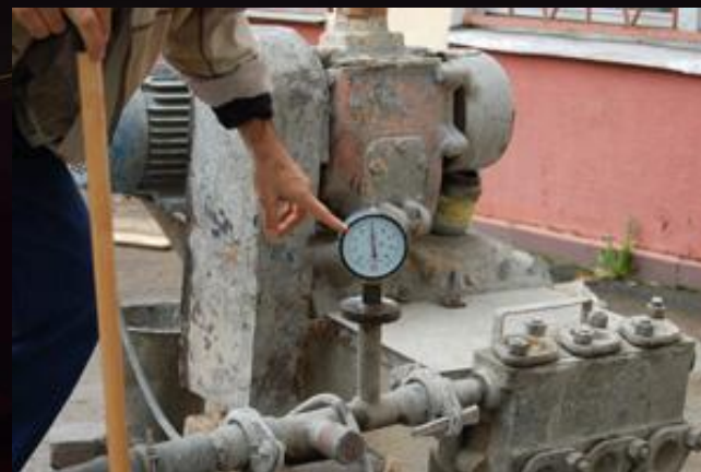
4. Контроль давления и объемов нагнетания
