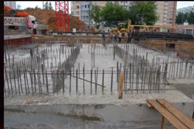
4. Готовая бетонная плита
