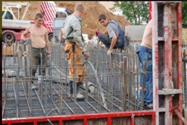
3. Заливка цементного раствора
