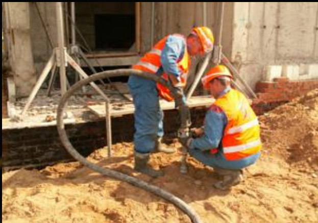
1. Присоединение нагнетательного шланга к инъектору
