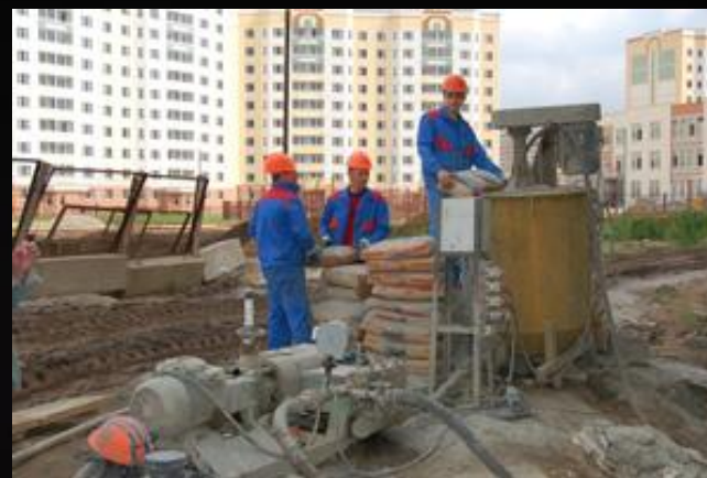
2. Приготовление цементного раствора
