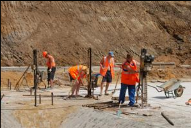
1. Бурение скважин, погружение инъекторов
