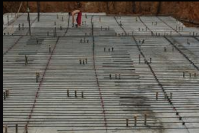
Монолитная ж/б плита
