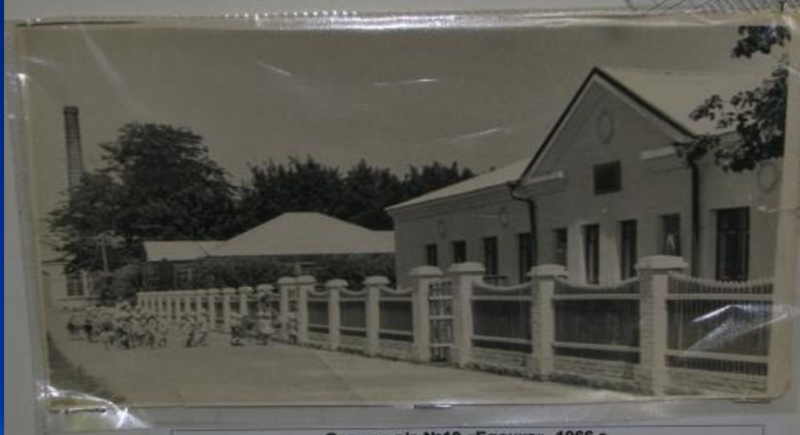
Здание д/с №10 «Елочка». 1966 г.
