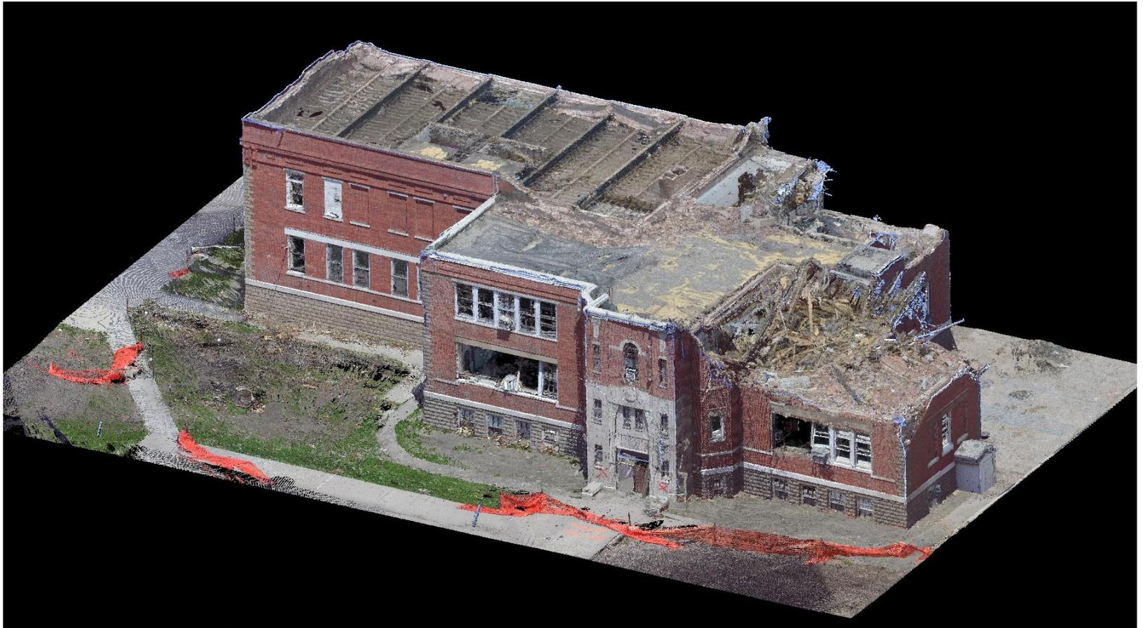
Рис. 3. Результат лазерного сканирования здания
