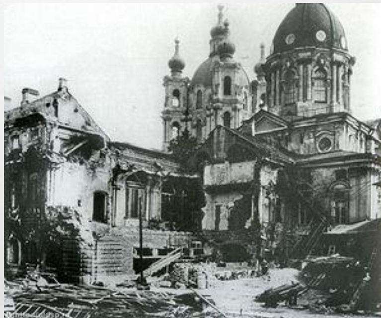
Разрушения в Смольном монастыре
