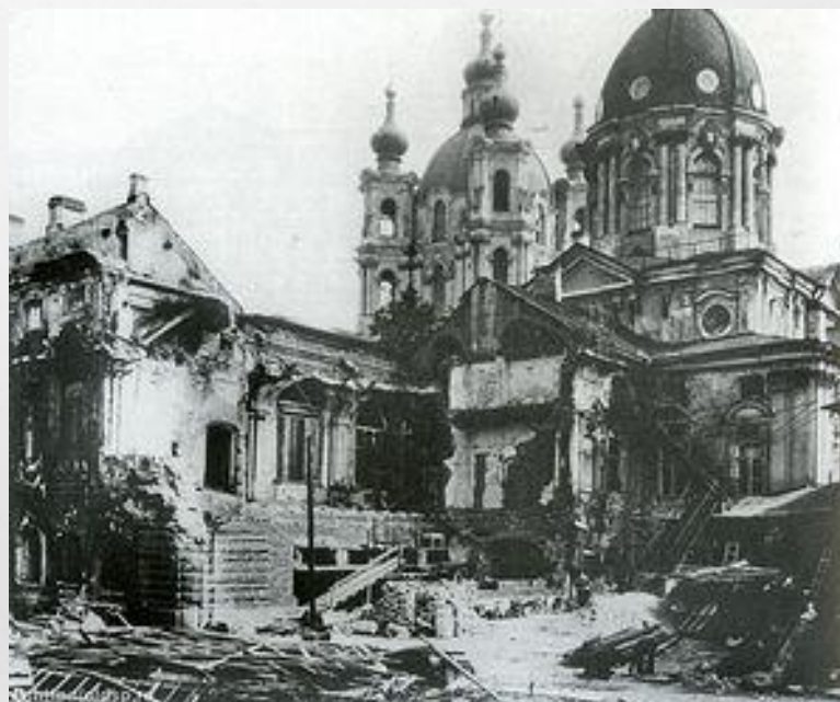
Разрушения в Смольном монастыре
