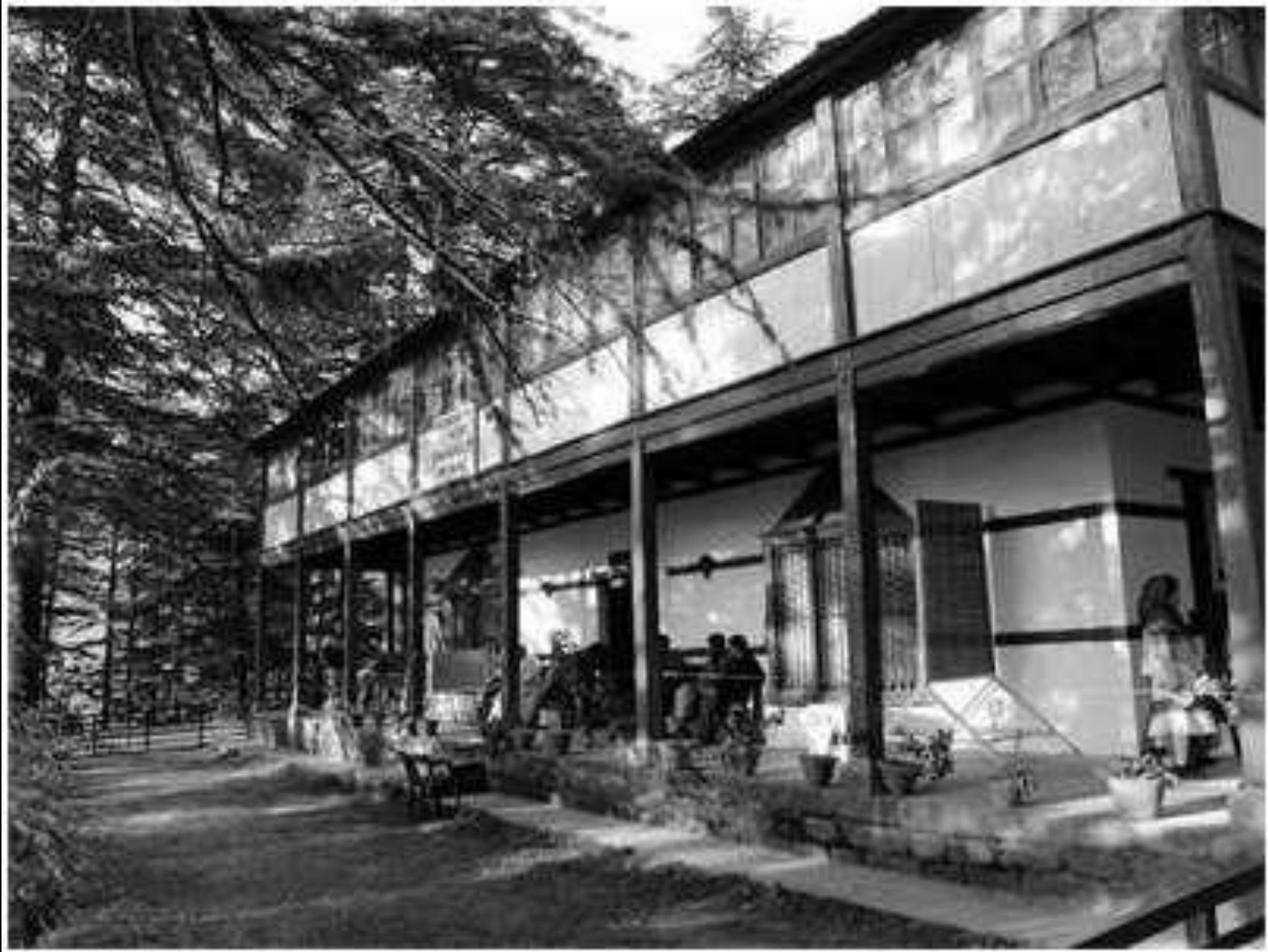
Основное здание Института Гималайских исследований «Урусвати».
