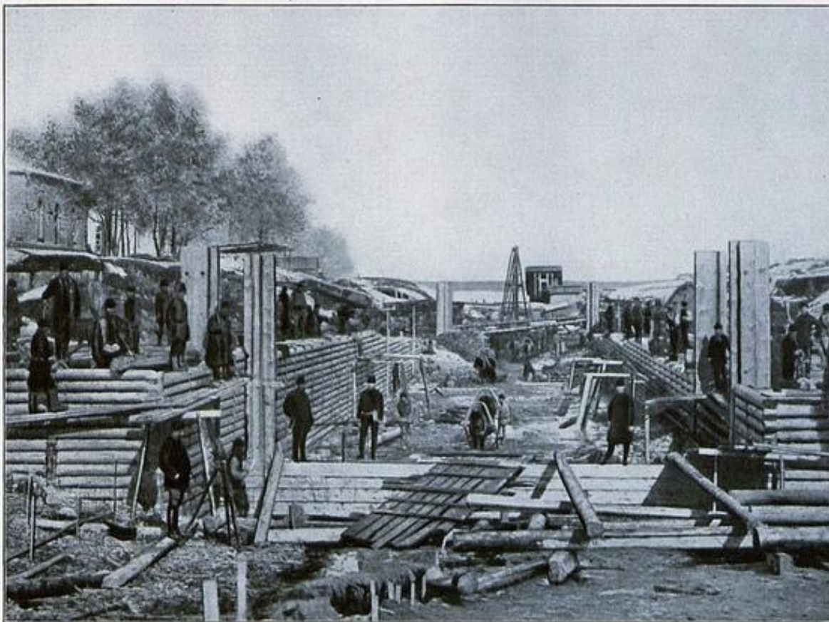
ПЕРЕУСТРОЙСТВО МАРИИНСКОЙ СИСТЕМЫ съ 1890 по 1896 годъ. Рубка стѣнь деревяннаго шлюза „Польза“ въ Ковжскомъ устьѣ Бѣлозерскаго канала.
