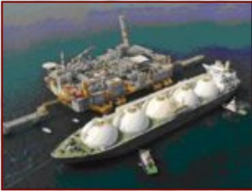
Завод по сжижению газа на платформе гравитационного типа
