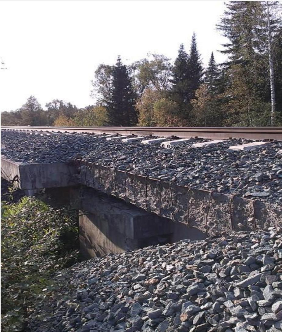
**Ширина плеча балластной призмы на реконструируемых и вновь построенных мостах должна быть 45 см, а толщина балластного слоя под шпалой в подрельсовой зоне 40 см.**
