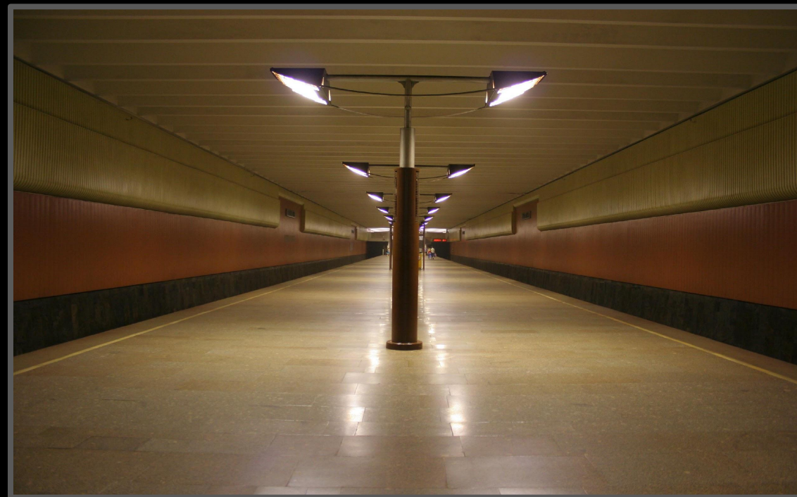
Однопролётная Волжская (Люблинско-Дмитровская линия) Глубина заложения 8м
