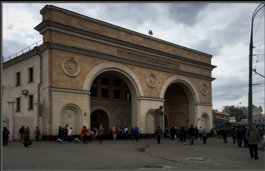
Наземный вестибюль станции «Добрынинская»
