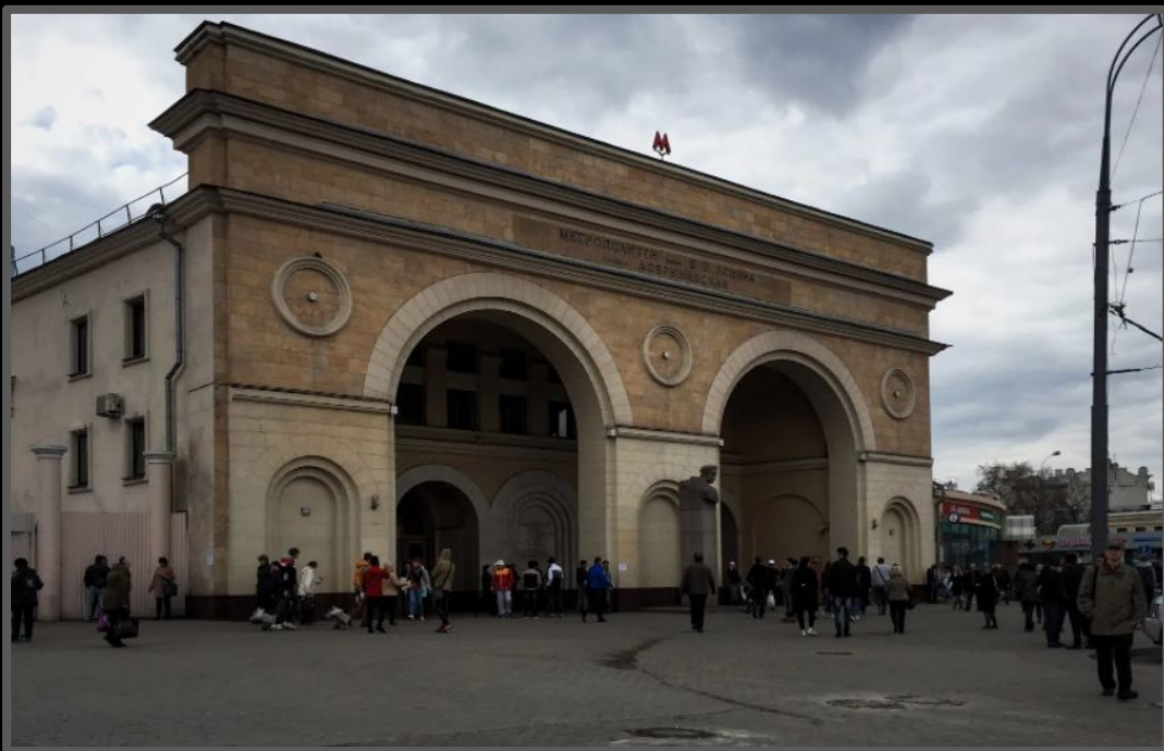
Наземный вестибюль станции «Добрынинская»
