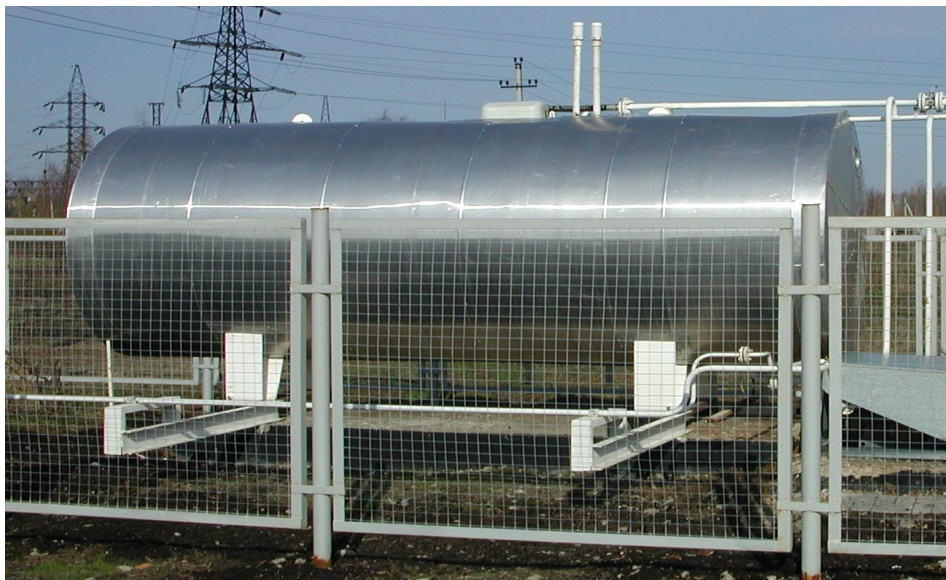
Общий вид резервуара с покрытием
