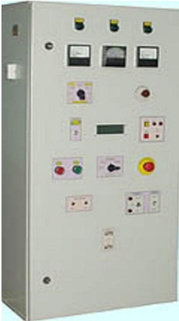
*Устройства автоматического контроля и управления* служат для контроля и управления ТП. Включают в себя датчики напруги, переключатели напруги, аварийные выключатели
