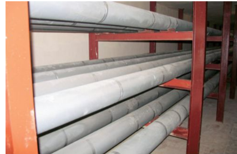
Прокладка магистралей в техническом коридоре
