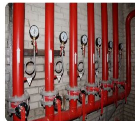
Противопожарные водопроводы
