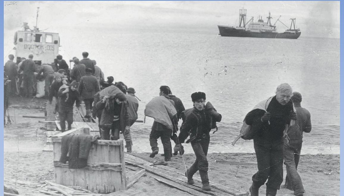
В короткий период была разработана новая технология с использованием бортовых самоходных барж, которые доставлялись в район выгрузки судами-снабженцами и перевозили груз от борта этих судов до берега. Выгрузка груза с барж осуществлялась с помощью тракторов и специальных волокуш, на которых груз тракторами волоком стаскивали с барж через аппарель и тащили до склада на берегу.
