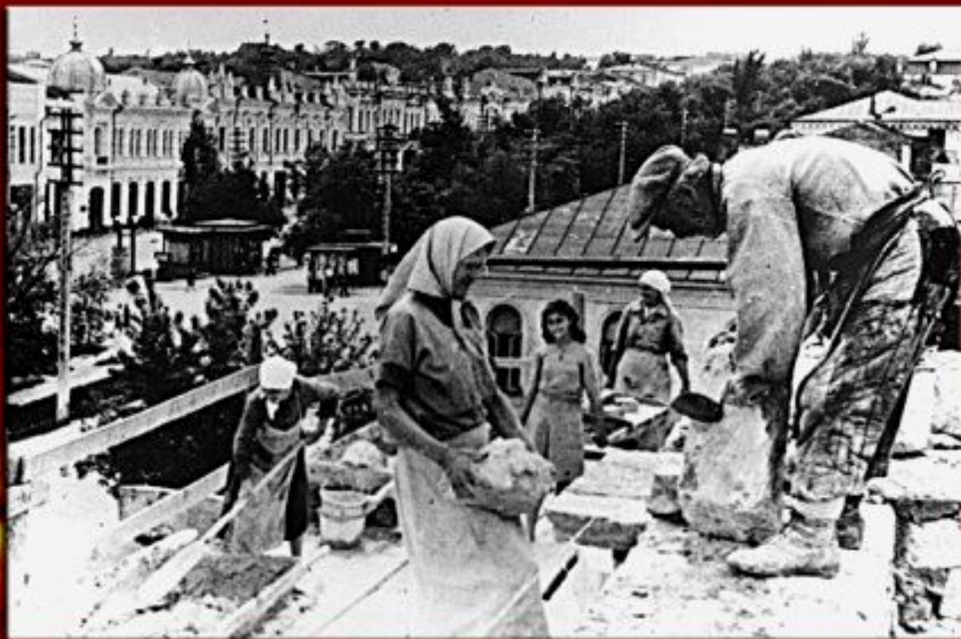
Восстановление здания драматического театра города Ставрополя 1943 год
