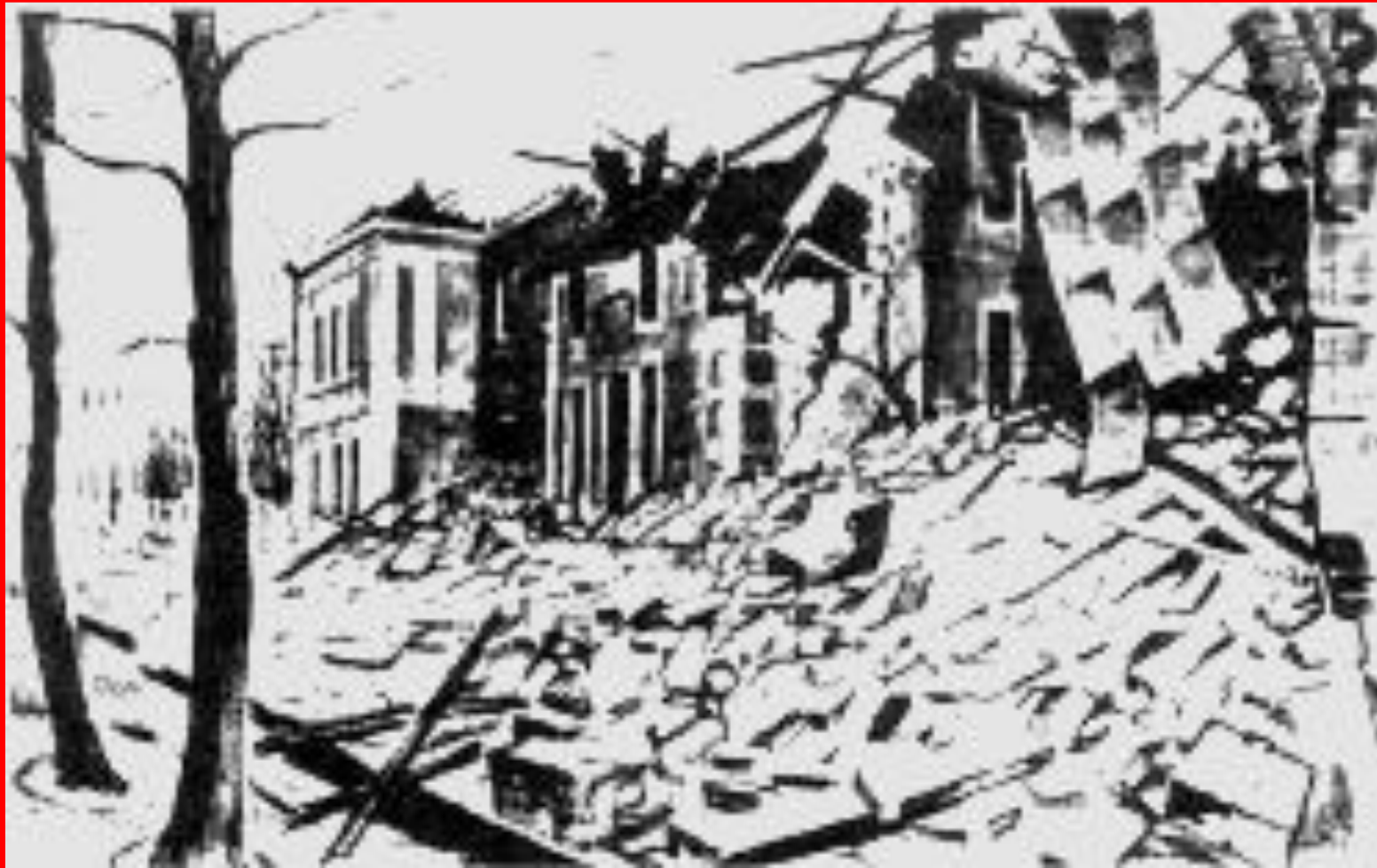
Разрушенная школа №1 Ставрополь.
