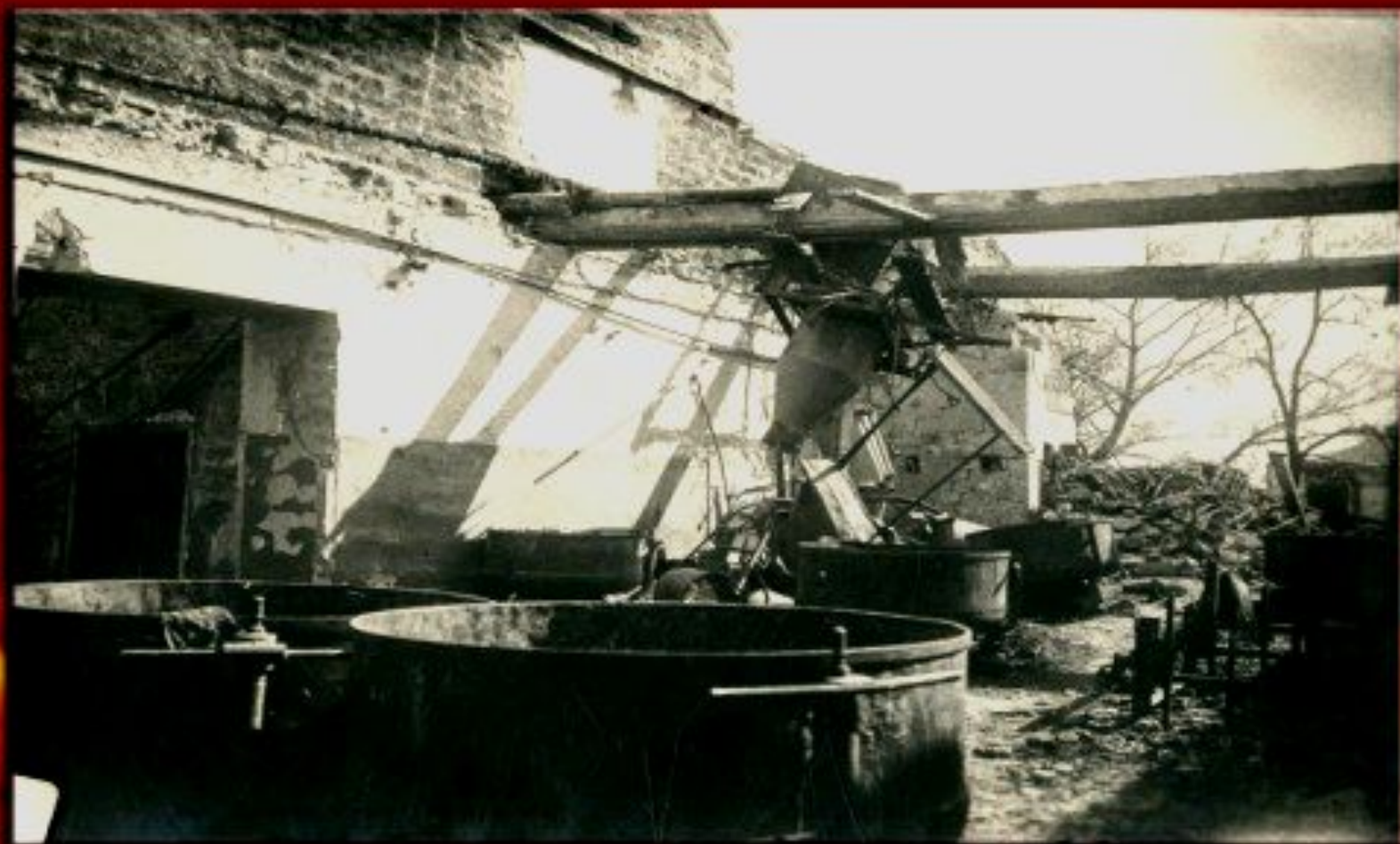
Ставропольский хлебокомбинат, разрушенный в период немецко-фашистской оккупации 20 марта 1943 года
