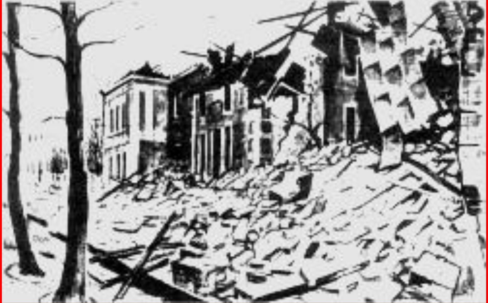
Разрушенная школа №1 Ставрополь.
