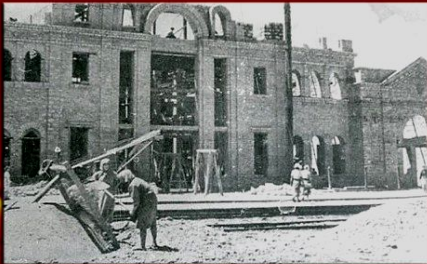
Восстановление железнодорожного вокзала города Ставрополя 1943 год
