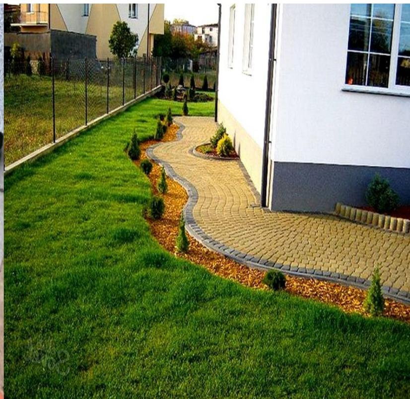
Все здания подвержены отрицательному влиянию природных факторов. При эксплуатации на фундамент оказывают воздействие осадки, грунтовые воды и отрицательная температура. Незащищенная основа постепенно разрушается, что вызывает усадку стен. Для комплексной защиты дома по его контуру сооружается специальная окантовка.
