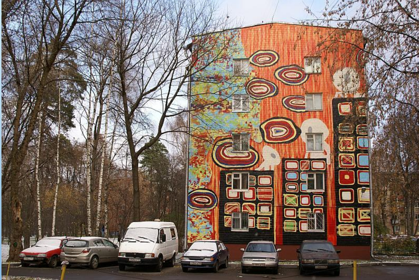
Суперграфика на фасаде
