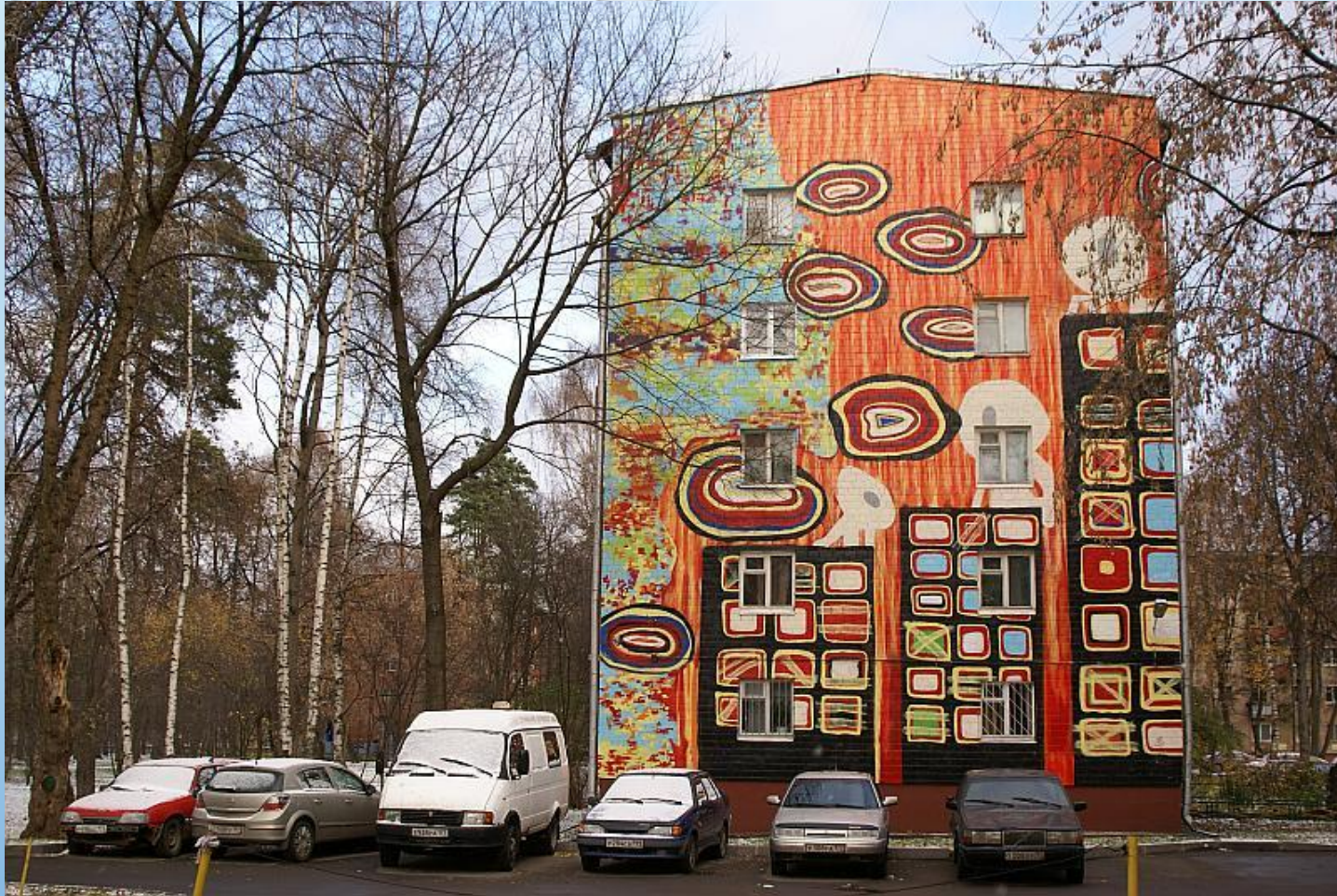
Суперграфика на фасаде
