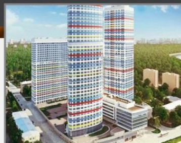
ЖК ТРИКОЛОР, г.Москва
