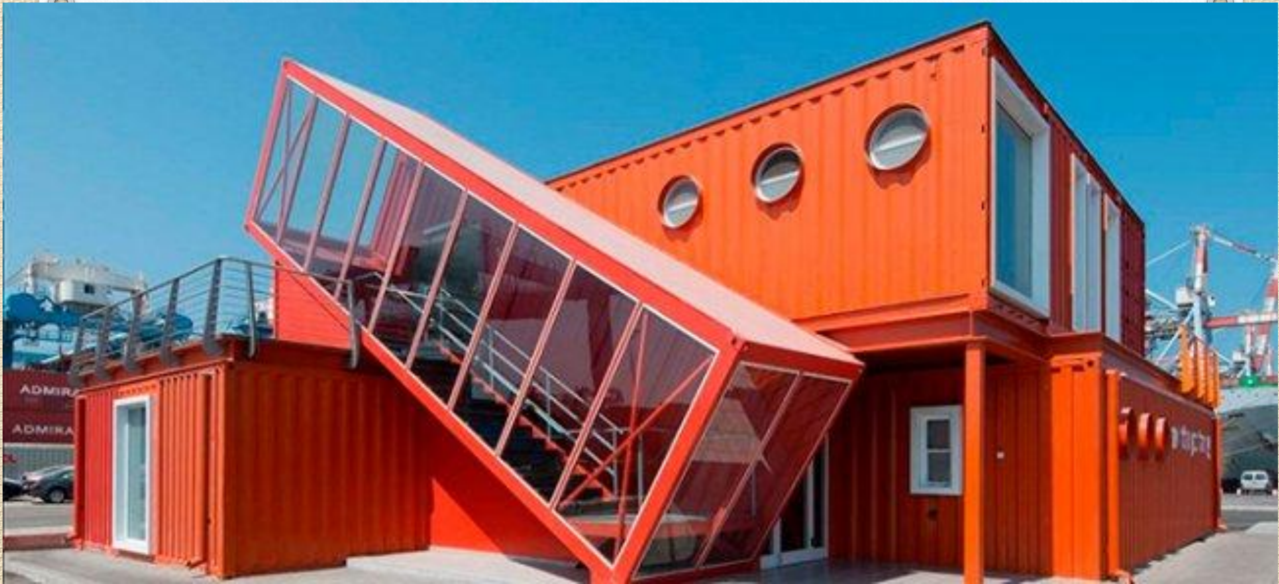
Дом из грузовых контейнеров
