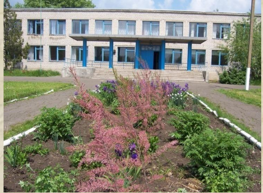
Современное здание школы
