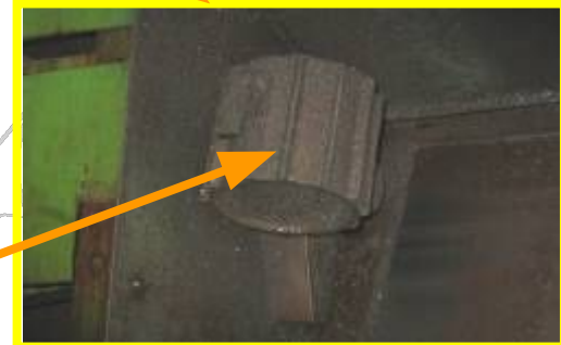
Отсутствие местного освещения
