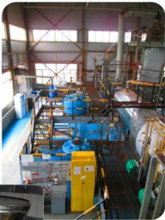
Узел восстановления Узел приготовления и дозирования реагентов
