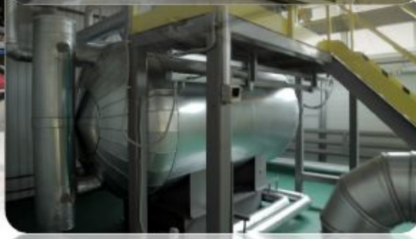
Узел отведения отходящих газов (дымосос, дымовая труба)
