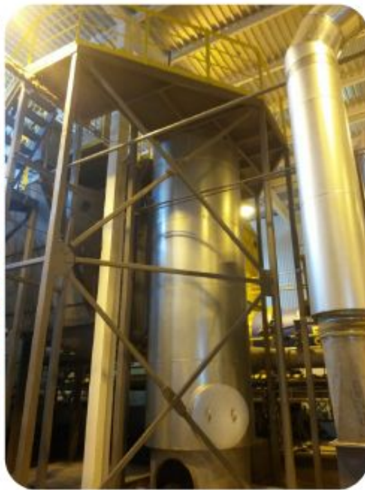
Узел реагентной нейтрализации газов
