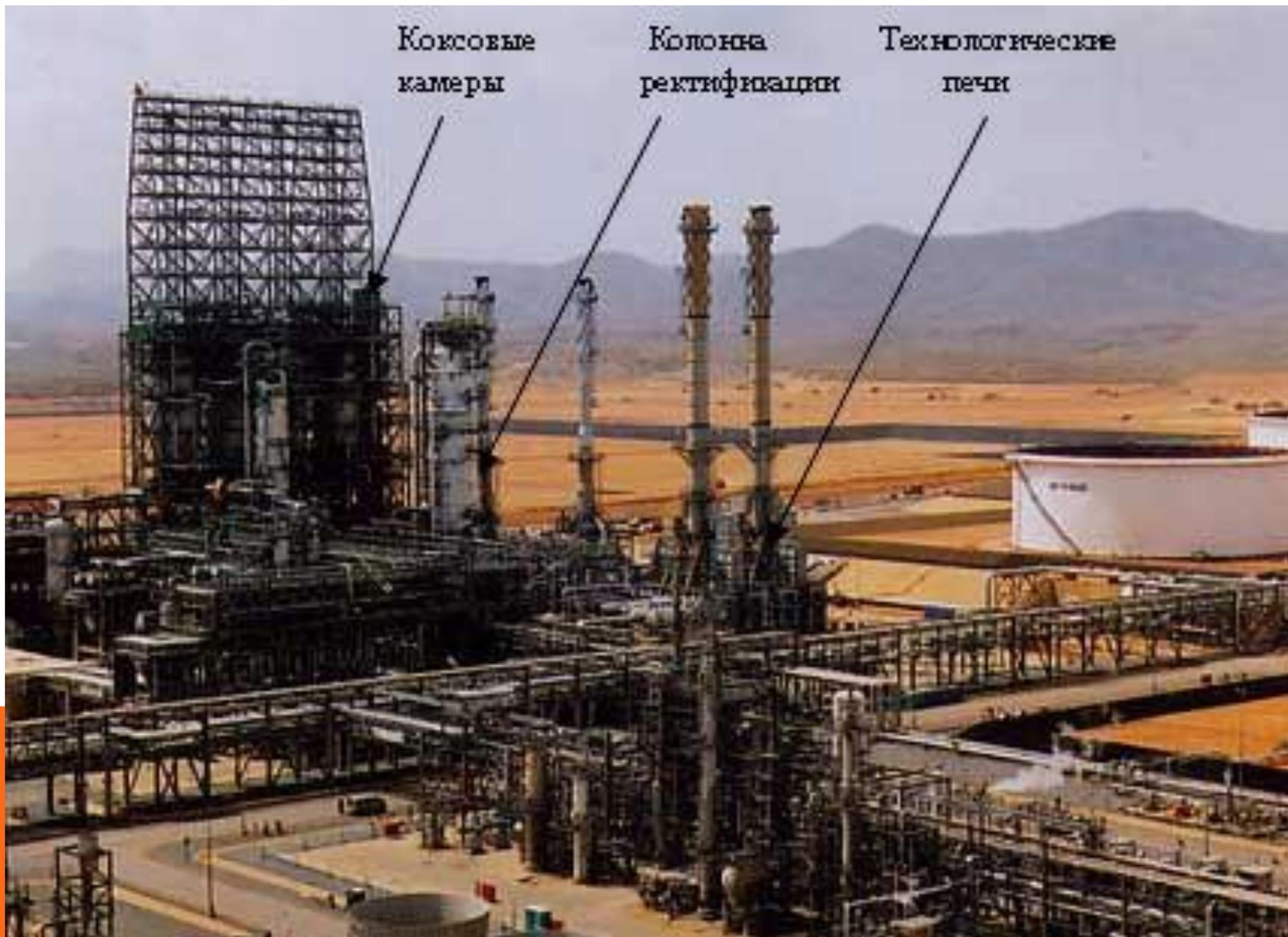
**Ректификационная колонна** – устройство, предназначенное для разделения многокомпонентной жидкой смеси на отдельные фракции по температуре кипения. Представляет собой цилиндр постоянного или переменного сечения, внутри которого находятся контактные элементы – тарелки или насадки.
