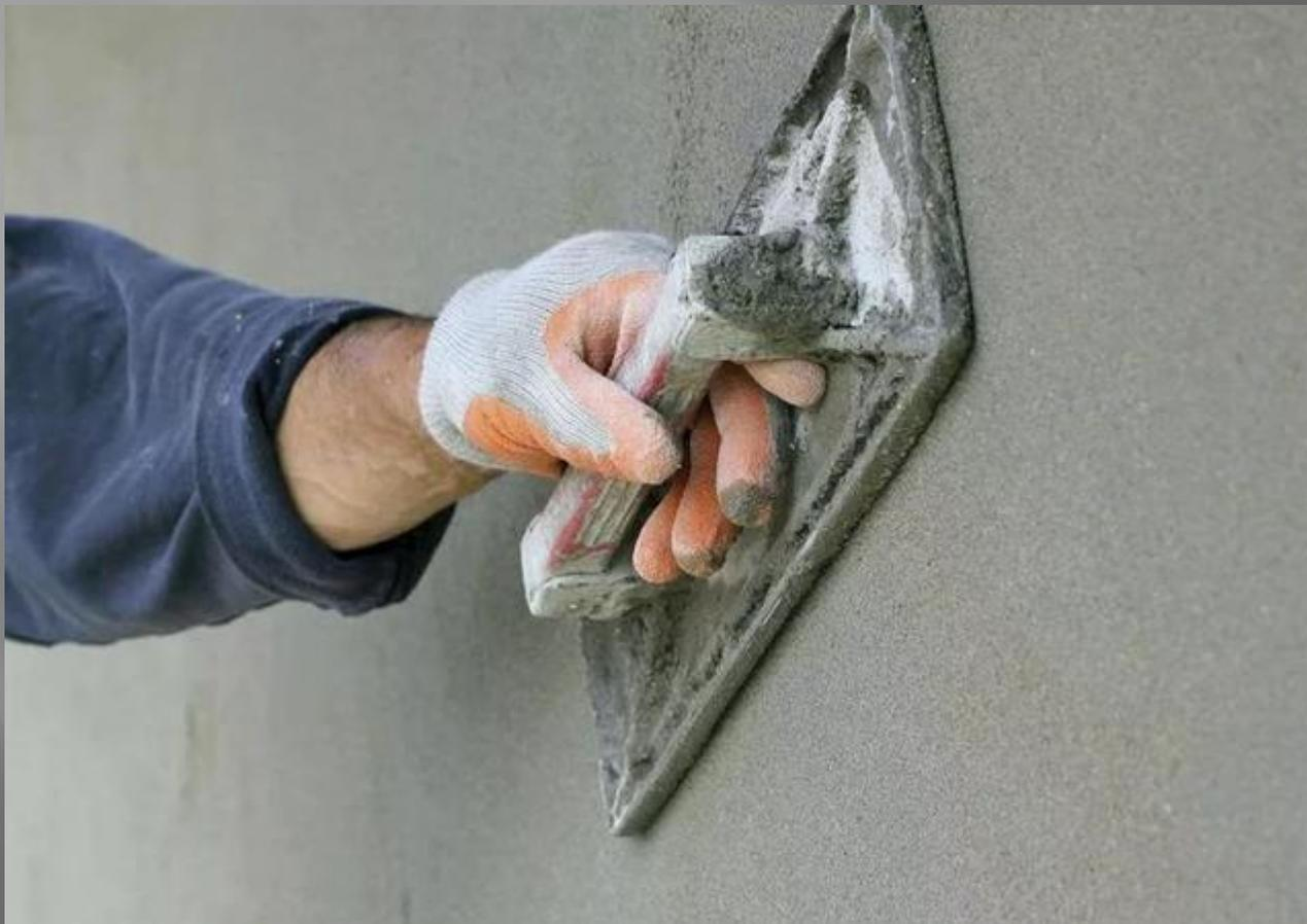
**Затирка поверхности - просохший грунт слегка увлажняют водой, когда слой раствора частично схватится выполняют затирку теркой или полутерком вначале дугообразными движениями, затем вразгонку прямолинейными движениями-взмахами.**
