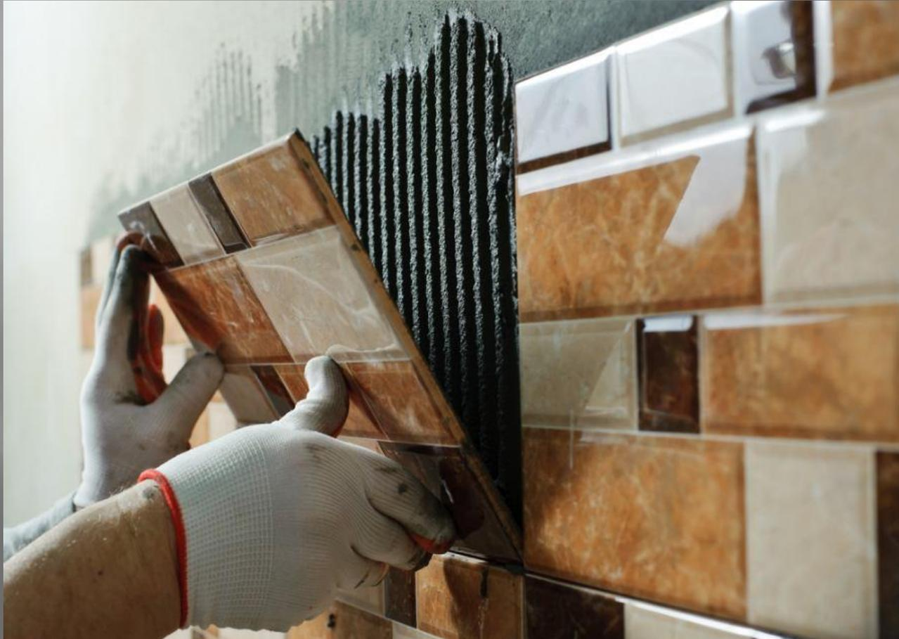
Стеклянные плитки укладывают на цементных растворах, на кислотостойких растворах, затворенных на жидком стекле, а также на глинобитумных мастиках состава 1 : 1.
