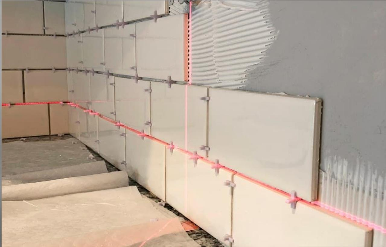
Первый ряд плиток раскладывают насухо, начиная от середины стены, и подсчитывают необходимое число плиток. Для определения вертикальных контуров облицовываемой поверхности устанавливают маяки.
