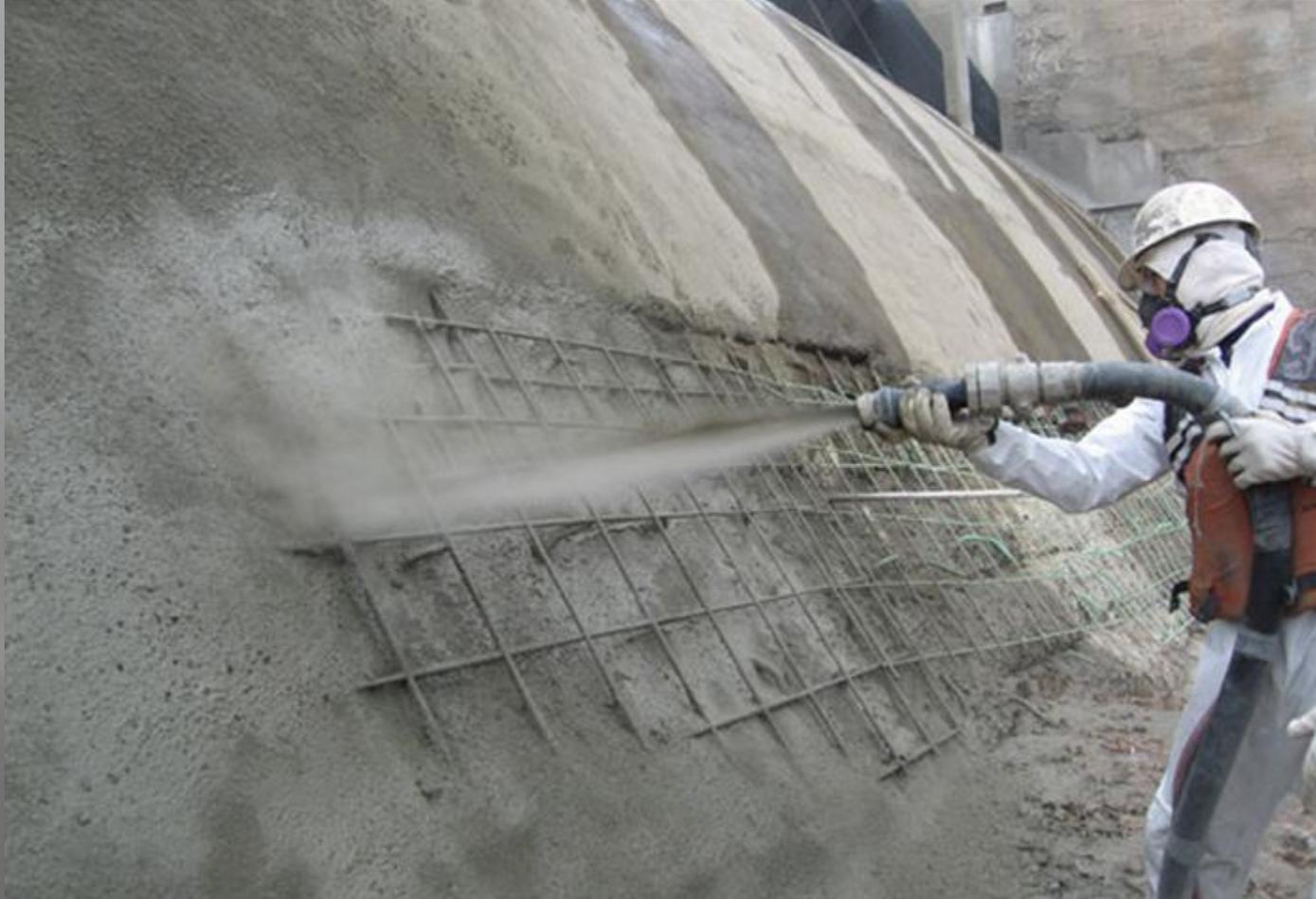
Торкрет-штукатурку используют в помещениях, подвергающихся сильному увлажнению (плавательные бассейны, водохранилища, сырые подвалы). Торкретирование поверхностей заключается в нанесении на каменную или бетонную поверхность цементного раствора с помощью сжатого воздуха.
