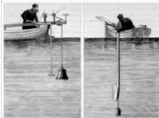
В жидкости скорость звука больше, чем в газе. Впервые скорость звука в воде была измерена в 1827 г. на озере в Швейцарии. На одной лодке поджигали порох и одновременно ударяли в подводный колокол. Другая лодка находилась на расстоянии 14 км от первой. Звук колокола улавливался с помощью рупора, опущенного в воду. По разности времени между вспышкой света и приходом звукового сигнала определили скорость звука. При температуре 8 °С скорость звука в воде равна 1435 м/с.
