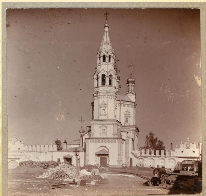
1703, Верхотурье, Троицкий собор. Историческое фото.
