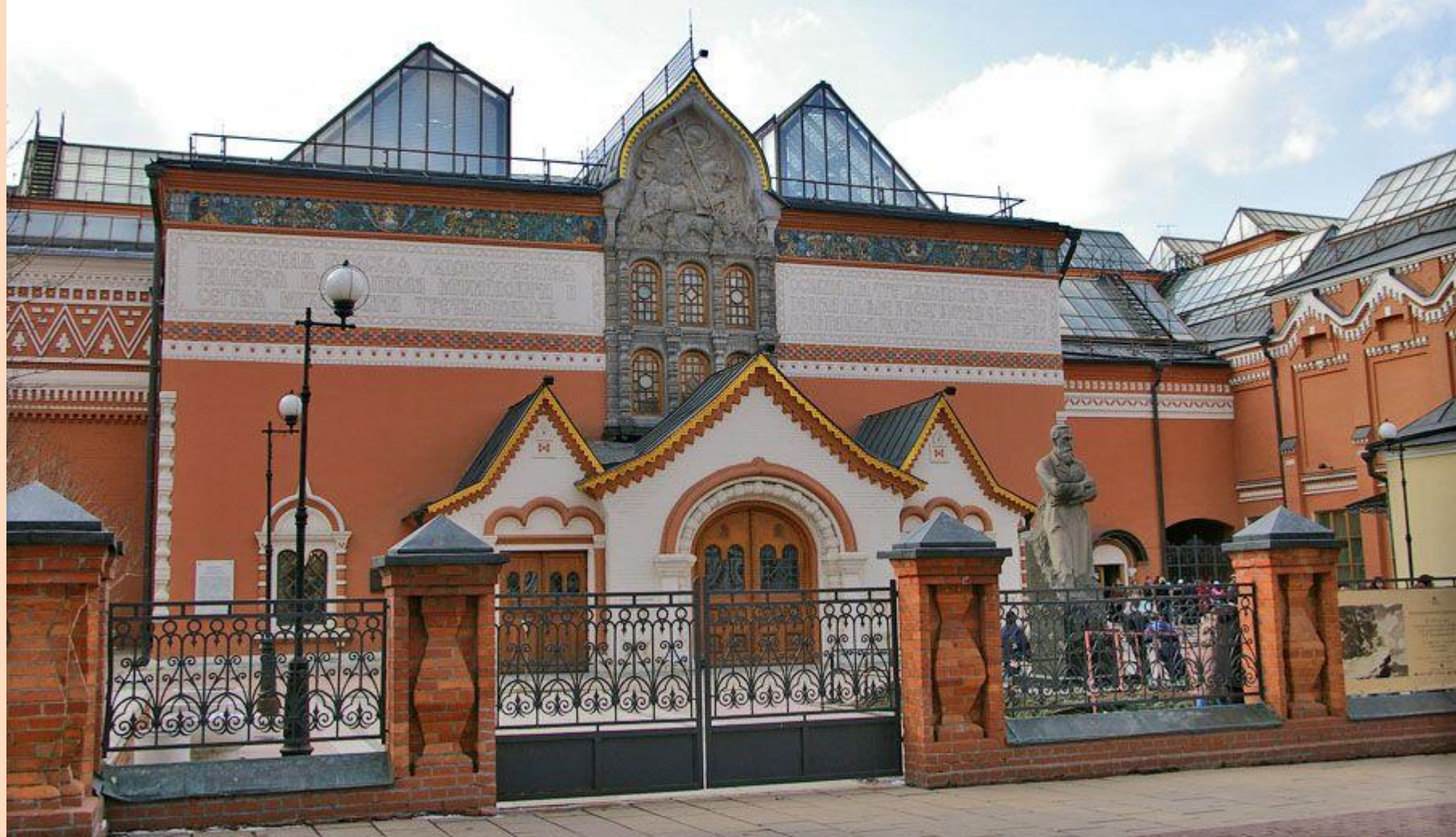
Третьяковская галерея. Дом куплен П.М. Третьяковым в 1851 г. Фасад разработан в 1900—1903 г.г. архитектором В. Н. Башкировым по рисункам художника В. М. Васнецова.
