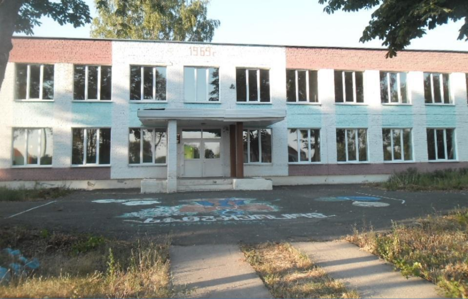
Двухэтажное кирпичное здание школы, аг.Савичи, ул.Юбилейная, д.32А
