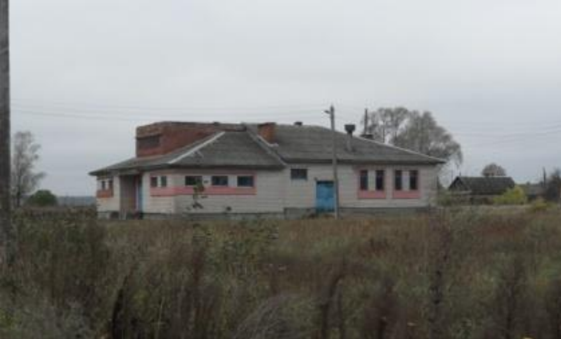
Здание бани, Наховский сельсовет, д. Нахов, ул. Садовая, 6
